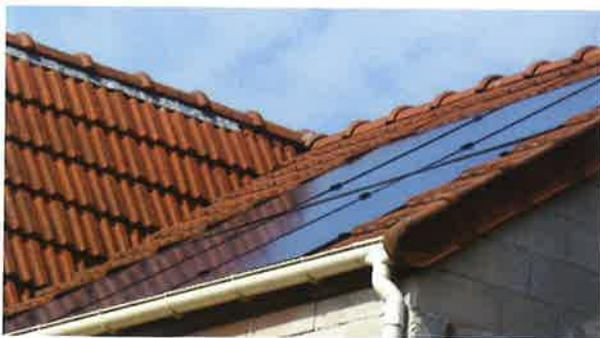
Si la technique le permet. Sinon, il est préférable de les positionner sur un autre support. Les capteurs encastrés sont affleurant du nu extérieur de la couverture (pas en saillies) sans surépaisseur ce qui limite l'impact visuel.
