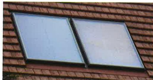
Thermiques : en panneaux ou en tubes. L'énergie solaire va permettre par exemple de chauffer de l'eau à destination des usages sanitaires, du système de chauffage d'une maison ou d'une piscine.
