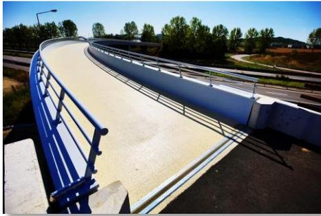
Début septembre, une passerelle cycles et piétons a été mise en service enjambant la RN12 et permettant de relier Plaisir à Elancourt dans la continuité du RD30. Cette passerelle en courbe, longue de 122 mètres et large de 5 mètres, est constituée d'éléments métalliques installés sur place. Le chantier a duré un an pour un coût total de 2,3 millions d'euros
